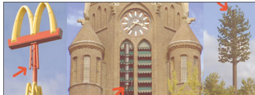
Figuur 10: voorbeeld van visueel onopvallende inpassing van antenne-installaties
