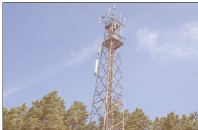
Figuur 8: voorbeeld van een vakwerkmast
