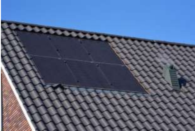
In het vlak- van de dakbedekking
