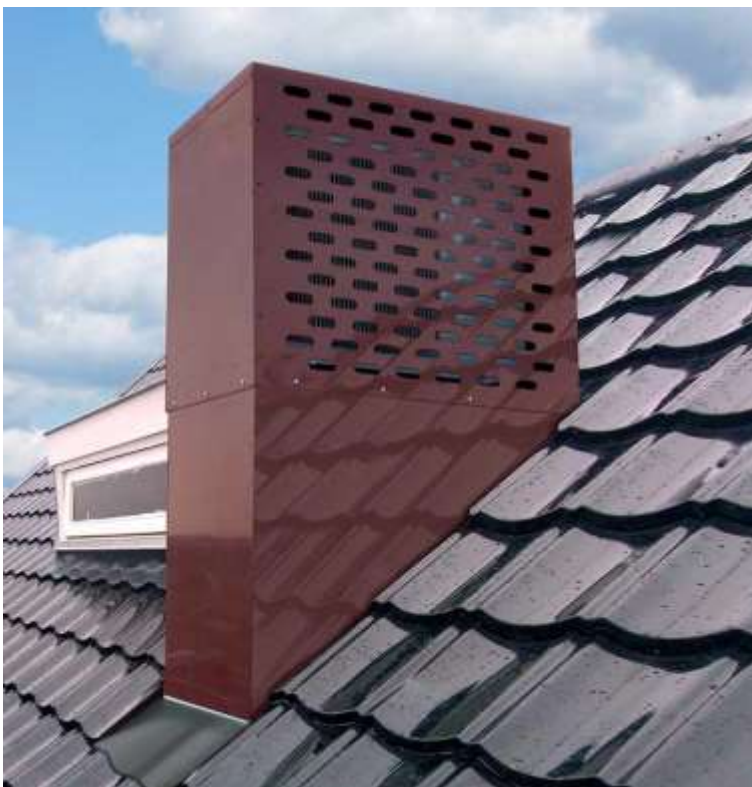
Buitenunit op het dak als 'schoorsteen'
