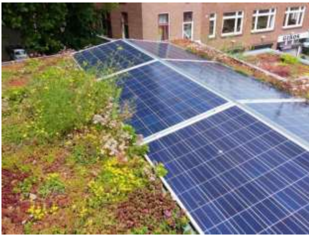
Op plat dak in combinatie met sedum
